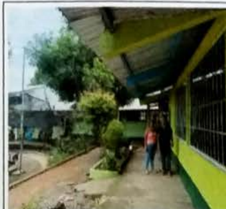
Foto 11: MODULO B Este modulo ya fue concluido dandole mantenimiento a la estructura de metal y el cambio de lamina de zinc por troquelada cal 26.
