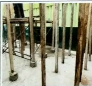
Foto 3: MODULO A Vista colocacion de paraleado para poder ensamblar la obra falsa que servira para colocar el emparrillado de la losa.
