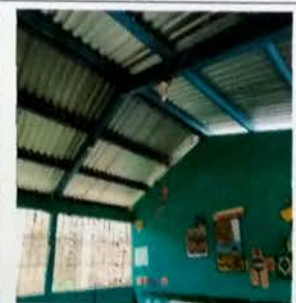
Foto 11: MODULO B Este modulo ya fue concluido dandole mantenimiento a la estructura de metal y el cambio de lamina de zinc por troquelada cal 26.
