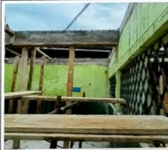
Foto 4: MODULO A Vista colocacion de paraleado para poder ensamblar la obra falsa que servira para colocar el emparrillado de la losa.
