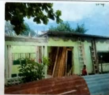
Foto 10: MODULO A del lado derecho donde fue sustituida la cubierta de asbesto y colcoada la estructura de metal con lamina troquelada cal 26, vista frontal donde se observa del lado izquierdo el area donde se esta realizando el trabajo de emparrillado para losa de concreto armado.
