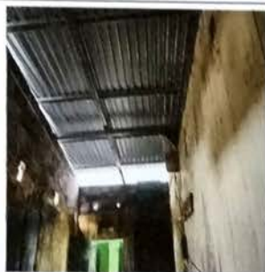
Foto 9: MODULO A area de bodega donde fue sustituida la cubierta de asbesto y colcoada la estructura de metal con lamina troquelada cal 26
