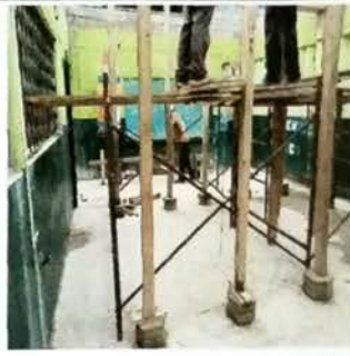
Foto 2: MODULO A Vista de parales de madera para entarimar las vigas que fueron fundidas con esperas para poder anclar tensiones y bastones de la losa.
