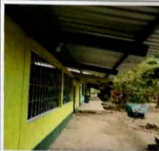
Foto 12: MODULO B Este modulo ya fue concluido dandole mantenimiento a la estructura de metal y el cambio de lamina de zinc por troquelada cal 26.
