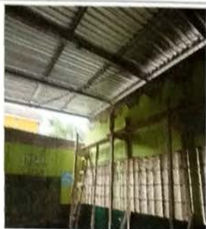
Foto 7: MODULO A Vista de AULA donde fue sustituida la cubierta de asbesto y colcoada la estructura de metal con lamina troquelada cal 26.
