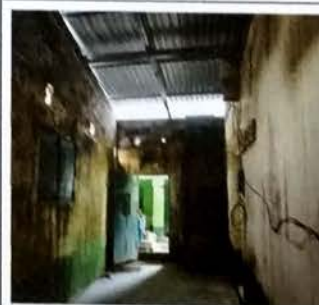
Foto 10: MODULO A del lado derecho donde fue sustituida la cubierta de asbesto y colcoada la estructura de metal con lamina troquelada cal 26, vista frontal donde se observa del lado izquierdo el area donde se esta realizando el trabajo de emparrillado para losa de concreto armado.
