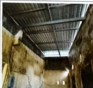
Foto 9: MODULO A area de bodega donde fue sustituida la cubierta de asbesto y colcoada la estructura de metal con lamina troquelada cal 26
