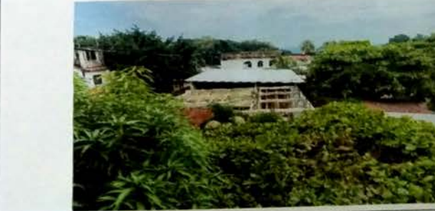
Foto 6: MODULO A Vista exterior panoramica donde se observa el area que se esta trabajando el armado de losa y el area que fue ya cubierta con lamina troquelada cal 26.
