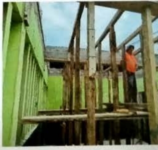
Foto 4: MODULO A Vista colocacion de paraleado para poder ensamblar la obra falsa que servira para colocar el emparrillado de la losa.
