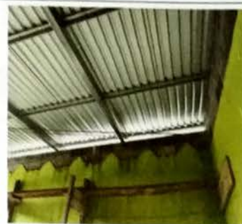
Foto 8: MODULO A Vista de AULA donde fue sustituida la cubierta de asbesto y colcoada la estructura de metal con lamina troquelada cal 26
