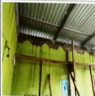
Foto 8: MODULO A Vista de AULA donde fue sustituida la cubierta de asbesto y colcoada la estructura de metal con lamina troquelada cal 26
