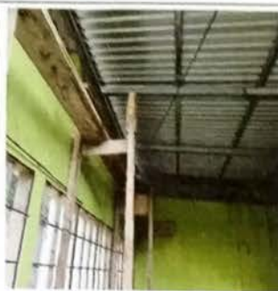
Foto 7: MODULO A Vista de AULA donde fue sustituida la cubierta de asbesto y colcoada la estructura de metal con lamina troquelada cal 26.
