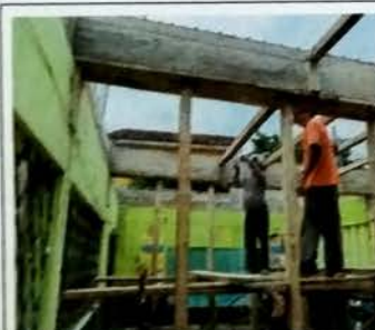
Foto 5: MODULO A Vista de parales de madera para entarimar las vigas que fueron fundidas con esperas para poder anclar tensiones y bastones de la losa.
