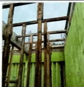
Foto 3: MODULO A Vista colocacion de paraleado para poder ensamblar la obra falsa que servira para colocar el emparrillado de la losa.
