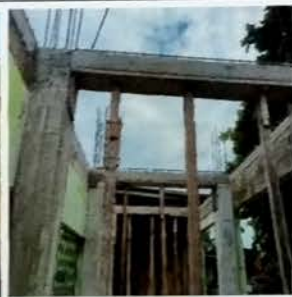
Foto 5: MODULO A Vista de parales de madera para entarimar las vigas que fueron fundidas con esperas para poder anclar tensiones y bastones de la losa.
