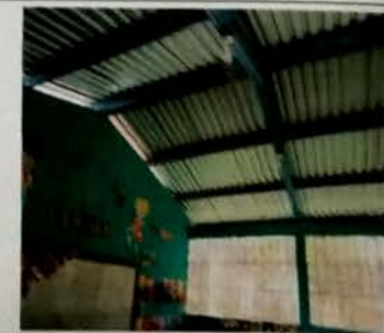
Foto 12: MODULO B Este modulo ya fue concluido dandole mantenimiento a la estructura de metal y el cambio de lamina de zinc por troquelada cal 26.
