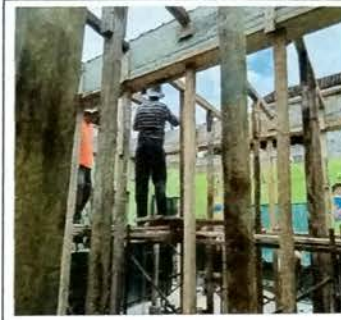
Foto 2: MODULO A Vista de parales de madera para entarimar las vigas que fueron fundidas con esperas para poder anclar tensiones y bastones de la losa.
